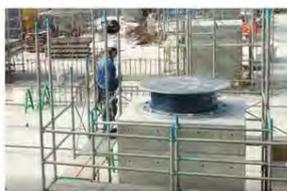
柱の上に設置された免震装置。地震時には変形して上の階に揺れが伝わらないようにします。
